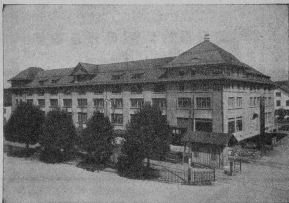
FABRIK IN USTER Bedachung in Eternit-Doppeldeckung, kupferbraun
