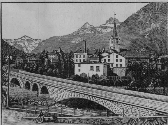
Eisenbahnbrücke ü. d. beiden Lintharme i. Schwanden
