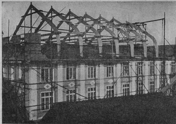
Stockwerksaufbau einer Fabrik nach Hetzer'scher Bauart.
