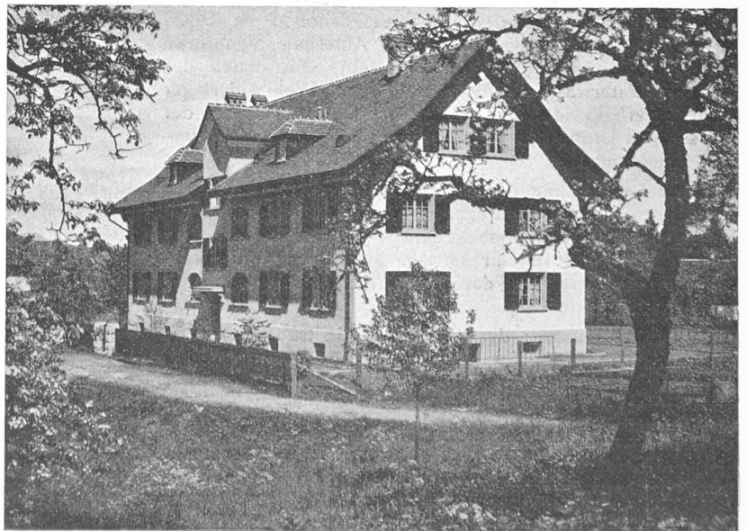
Abb. 7. Beamtenwohnhaus der Firma Pfenninger &amp; Cie. A. G. in Wädenswil.
