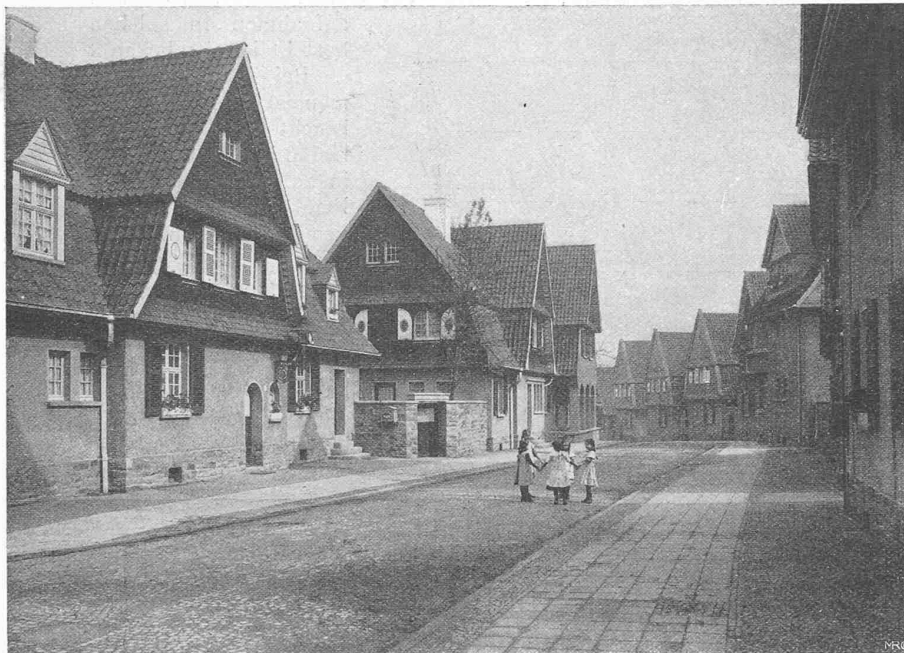
Abb. 1. Einfamilienhäuser an der „Steilen Strasse“, Kolonie „Margarethenhöhe“ bei Essen.
