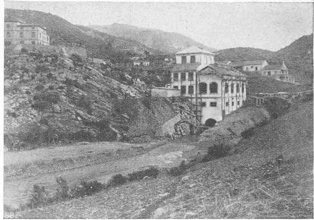
Fig. 21. Vue d'aval de l'usine de Buitreras sur le Guadiaro.
