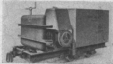
Motor-Triebwagen 6 PS
