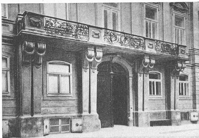
Abb. 4. Portal der Ungarischen Hofkanzlei in Wien.
