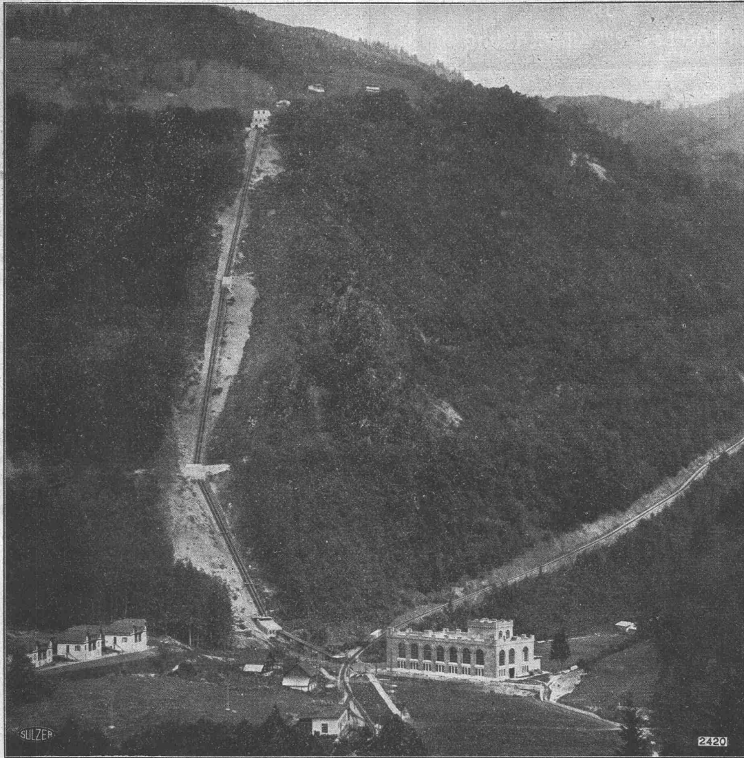
Hochdruckrohrleitungen des Elektrizitätswerkes Obermaif-Engelberg der Stadt Luzern
