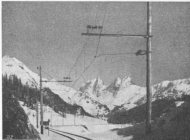
Abb. 2. Holzmasten mit geraden Auslegern.
