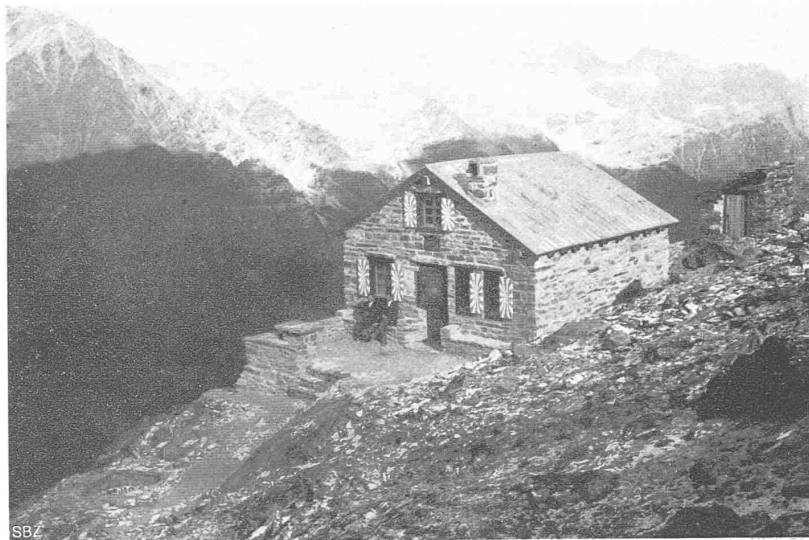
DIE DOM-HÜTTE DER S.A.C.-SEKTION UTO ERBAUT 1890 DURCH ARCH. REUTLINGER-ULRICH IN ZÜRICH ERWEITERT 1919 DURCH GUSTAV KRUCK UND HEINR. BRÄM
