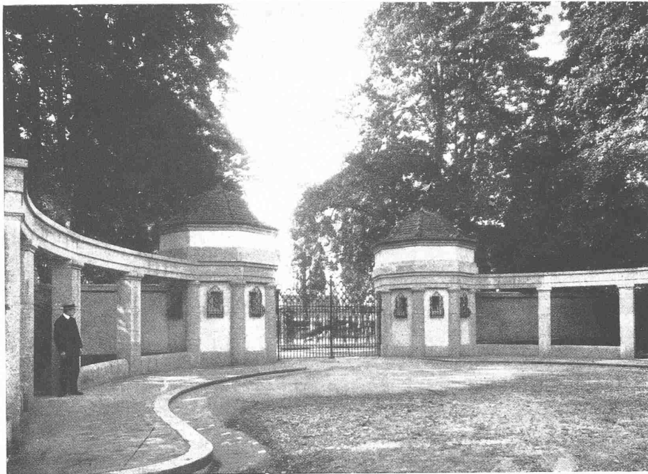
AUSSEN-ANSICHT DES PORTALS MIT VORPLATZ
