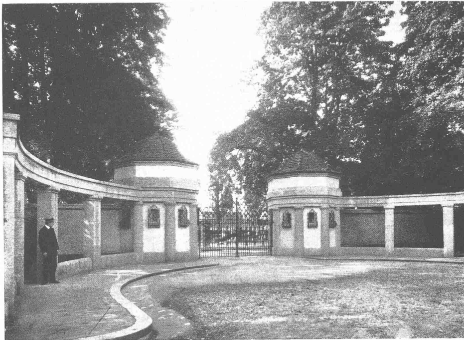
AUSSEN-ANSICHT DES PORTALS MIT VORPLATZ
