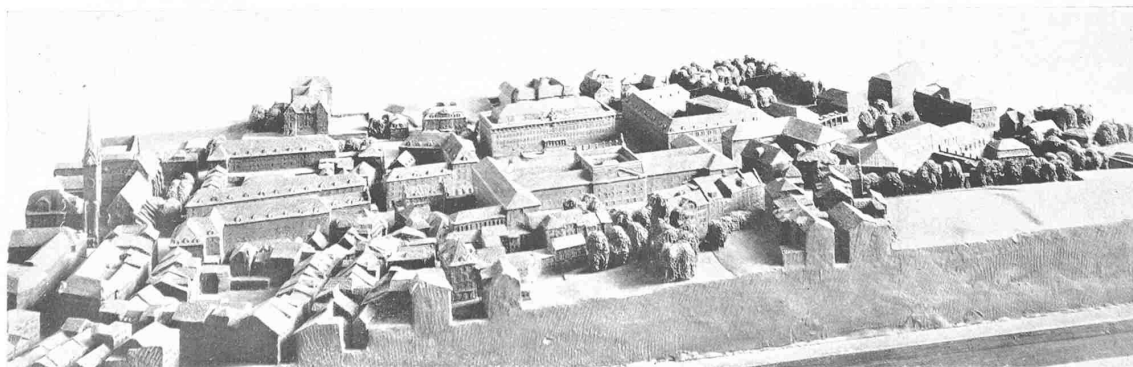
I. Preis Entwurf Nr. 18. — Arch. Pflughard &amp; Häfeli, Zürich. — Modell-Ansicht aus Südwesten.
