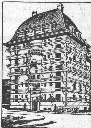
Ansicht eines eingerüsteten Hauses
