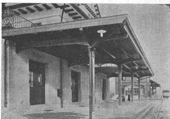
Perrondach Oberwinterthur. Frei au liegende Konsolträger.
