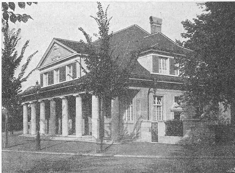
Abb. 2. Polizeiposten am Wielandplatz in Basel.
