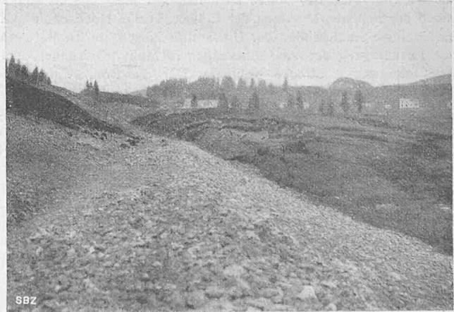
Abb. 30. Bodenaufpressung seitlich des Bahndammes im Sumpf des Doubstales bei l'Abergement.
