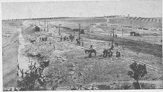
Abb. 67. Vom Bau des Damms Nr. 2. (20. Juli 1913.)
