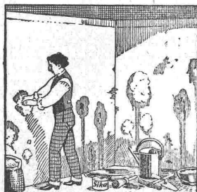
Wasserdurchlässige Stellen in Böden und Wandputz werden mit schnellbindender „SIKA“ verdichtet.
