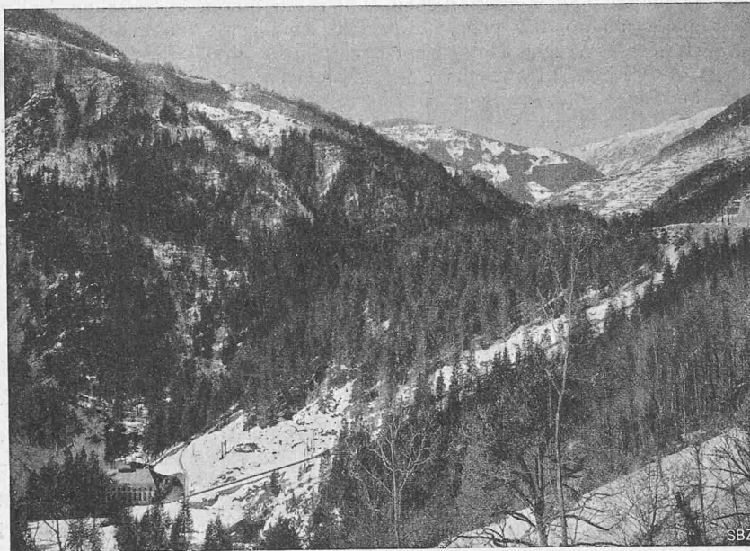
Abb. 23. Uebersicht talauswärts der untern, offen verlegten Druckleitungsstrecke.
