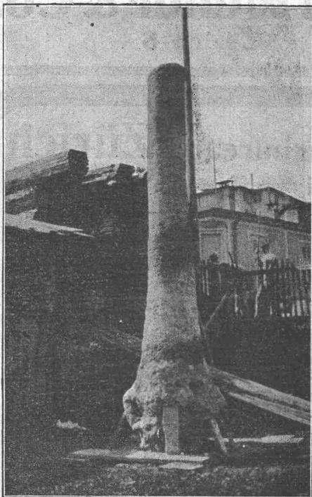
Nebenstehend: Ausgegrabener Press-Betonpfahl bei einer Fundation
