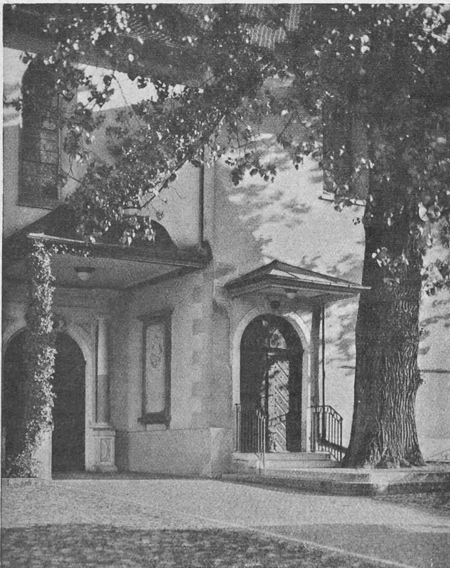
Abb. 2. Nordwestlicher Kircheneingang und Emporencgang.
