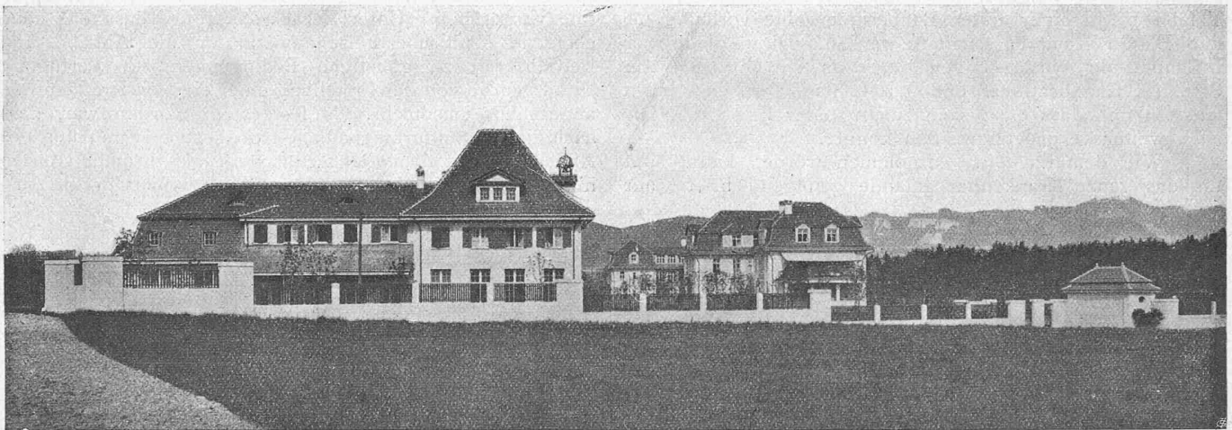
Abb. 13. Ansicht der Gemeindespital-Bauten von Südwesten, links das Oekonomiegebäude, rechts der Haupteingang.
