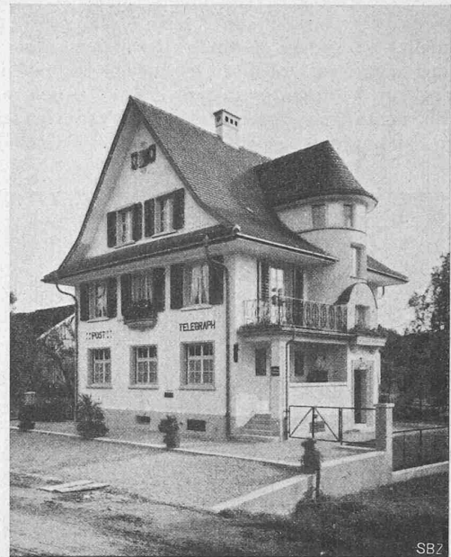
Abb. 8. Einfamilienhaus Metzger in Kollbrunn (Tösstal).
