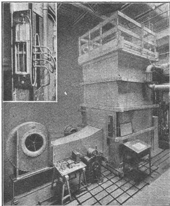
Prüfstand für Ventilatoren
