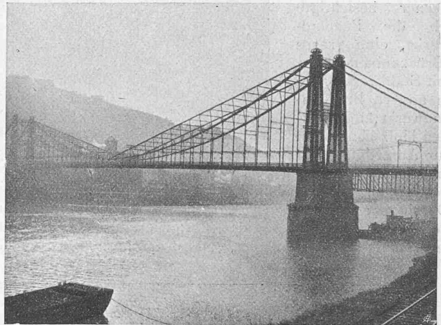
Abb. 33. Point-Brücke über den Monongahela in Pittsburgh, erbaut 1877.
