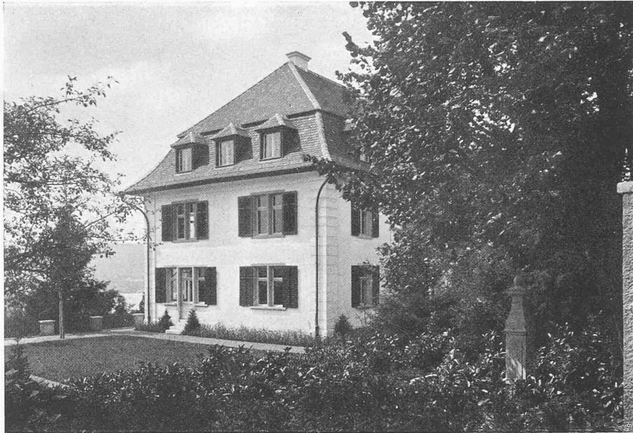
OBEN: BLICK VOM OEKONOMIE-GEBÄUDE GEGEN DIE SÜDOSTFRONT
