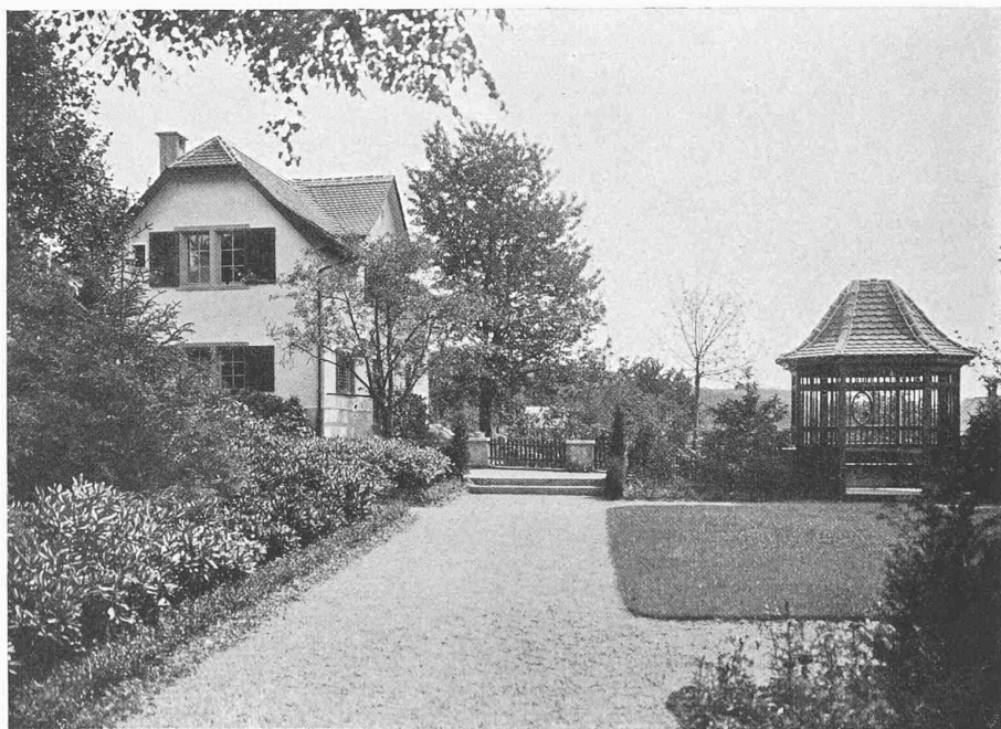
UNTEN: BLICK VON DER RÜCKSEITE DES HAUSES GEGEN SÜDOST
