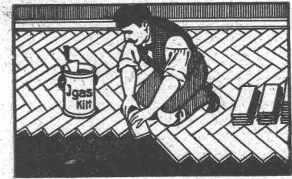
Parketts etc. in „IGAS“ zu verlegen.
