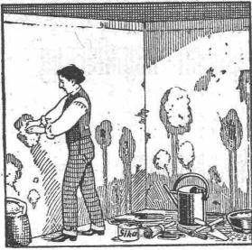
Wasserdurchlässige Böden und Wände werden mit schnellbindender „SIKA“ verdichtet.
