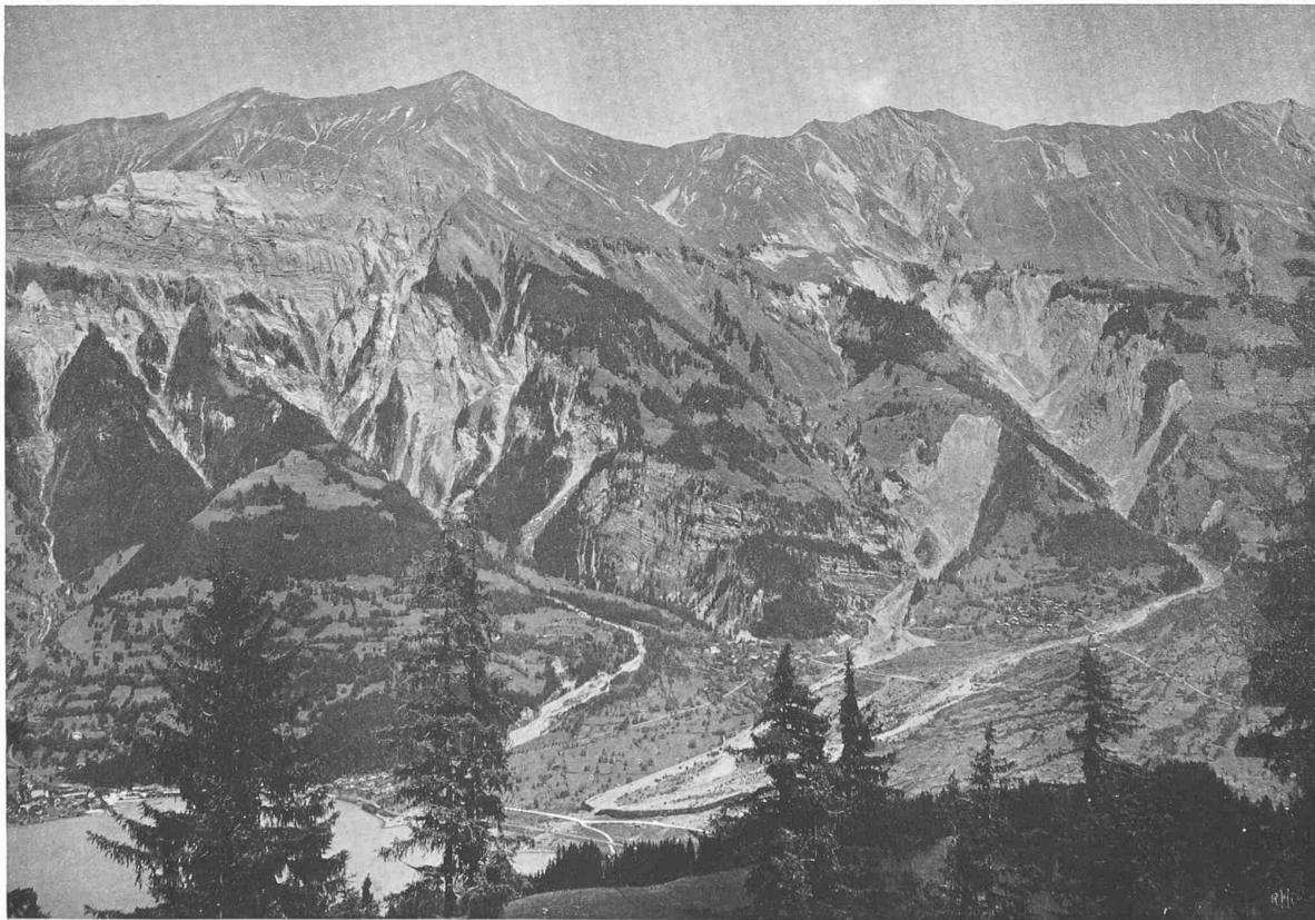
Verbauung des Lambbaches; unten: Gesamtansicht, oben: Sperre Nr. 5 und Schale (Original-Clichés des Buches).
