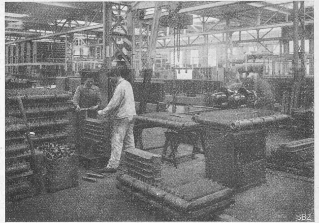
Abb. 18. Zusammen-Nippeln der Elemente zu Radiatoren.
