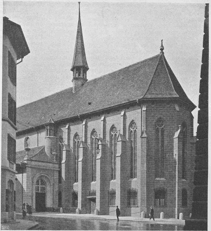
Abb. 5. Umgebautes Chor, von Südosten gesehen.
