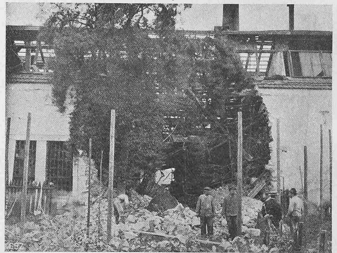
Abb. 2. Vom abgesprengten Deckel durchschlagene Mauer.
