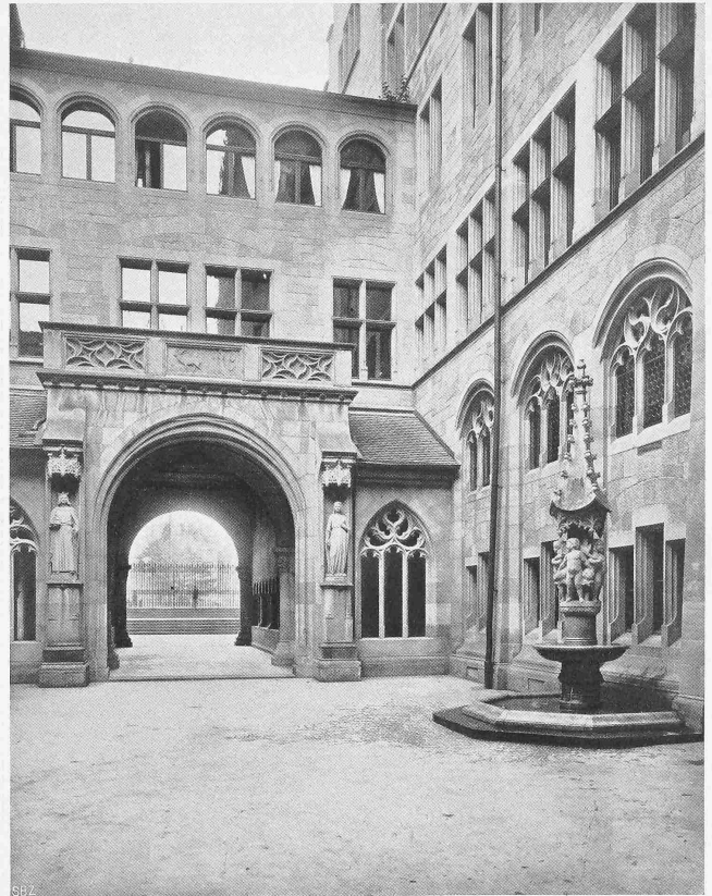
DER HOF GEGEN DAS STADTHAUS, ERBAUT 1900
