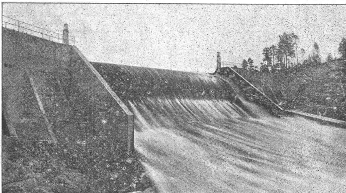
Selbsttätiges Ueberfallwehr Osfaldet für Aamot kommunale Elektricitetsverk (Norwegen)
