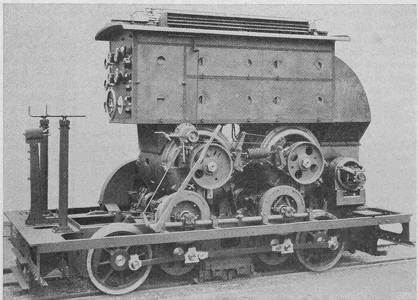
Abb. 15. Dreiphasen-Wechselstrom-Lokomotive der Jungfrauabahn mit abgehobenem Kasten.
