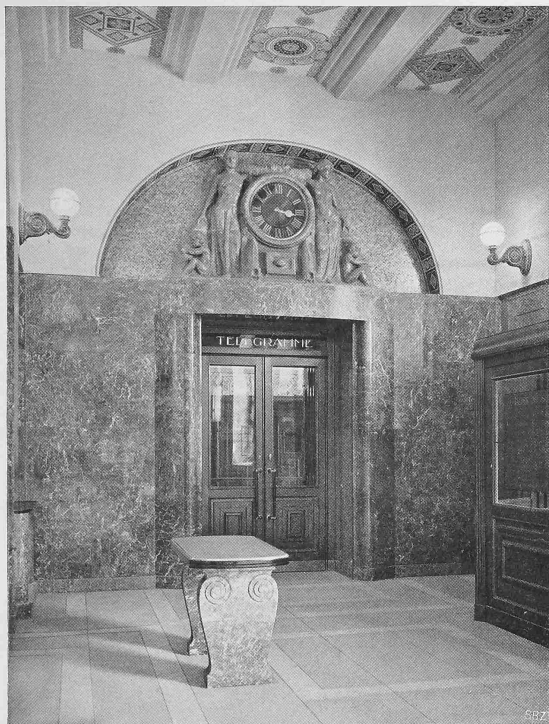
WESTLICHES ENDE DER SCHALTERHALLE
