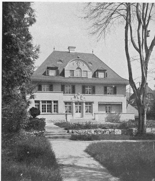
DAS HAUS MERKER IN BADEN ARCH. BRIDLER & VÖLKI, WINTERTHUR
