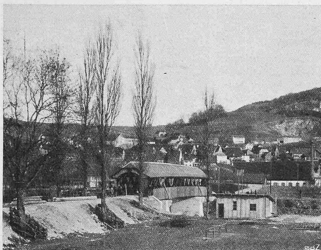
Abb. 10. Die Brücke und Münchenstein von Westen.
