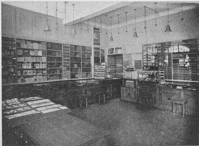
Abb. 9. Laden I im Erdgeschoss des «Rösslitor».
