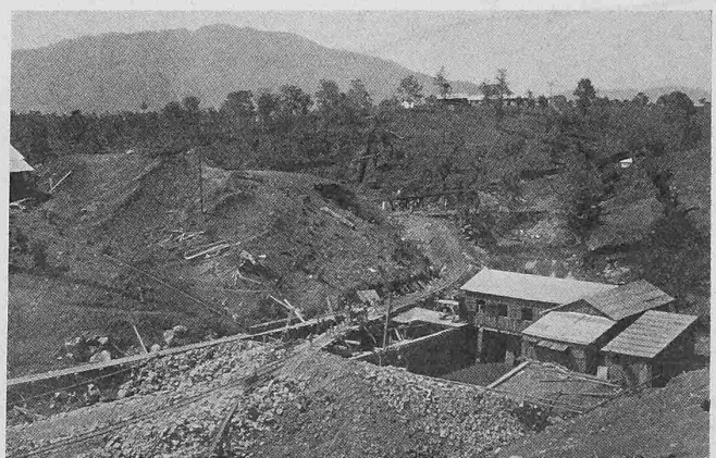
Abb. 9. Reservoir und erstes Pumpenhaus am untern Dammfuss.
