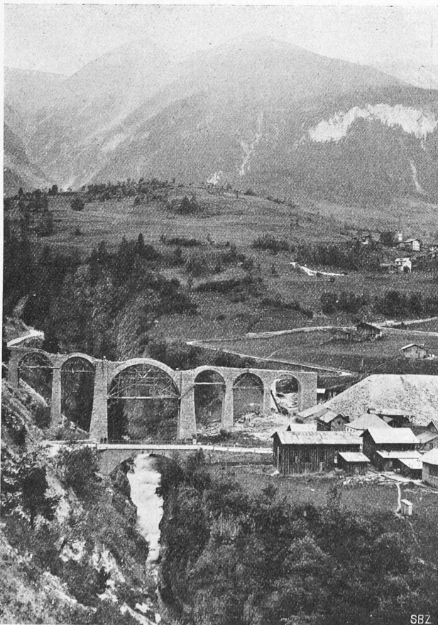
Abb. 11. Gremiols-Viadukt im Bau, Hauptöffnung 22 m.
