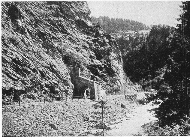
Abb. 7. Steinschlaggalerie im Rieiner-Tobel.
