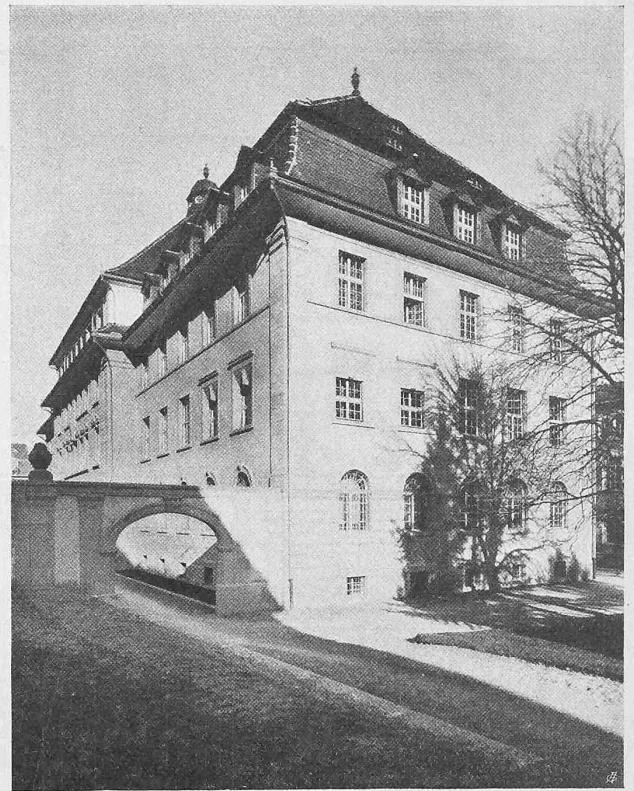
Abb. 4. Ansicht des Verwaltungsgebäudes von Süden.
