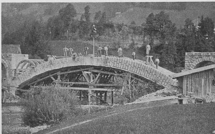
Abb. 21. Thurbrücke bei Km. 6,650 nach Vollendung des Hauptbogens.
