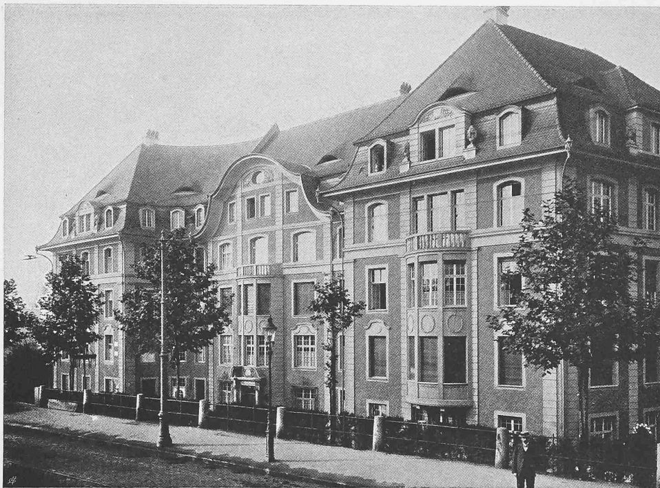
Ansicht von der Viaduktstrasse und von der Birsigstrasse aus
