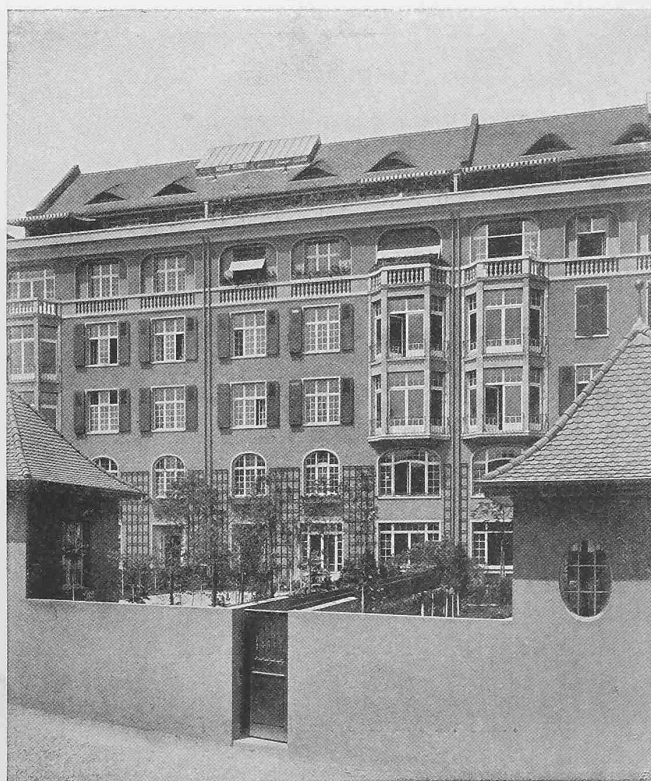
MIETHAUSGRUPPE „AM VIADUKT“, VON ARCH. RUD. LINDER, BASEL
