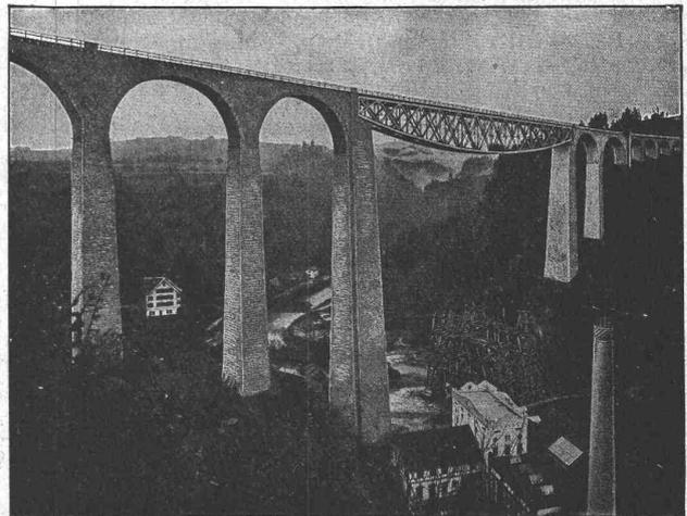
Sitterbrücke 900 Tonnen mit teilweise abgebrochenem Montagegerüst.
