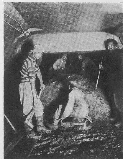
Abb. 9. Innenansicht einer Arbeitskammer.
