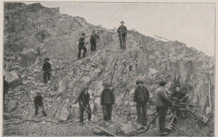
Marteaux perforateurs „Meyer“ et perforatrice sur trépied dans la carrière de grauwacke „Listernohl“.
