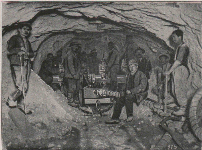
Travaux d'avancement au tunnel du Loetschberg
