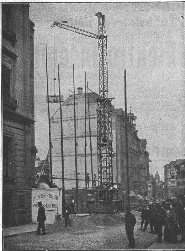
1 fahrbarer Turmdrehkran mit einem Motor ohne Wendegetriebe für Heben und Fahren. Zwei Hubgeschwindigkeiten. 1,5-3 t Tragkraft, 9-5 m Ausladung, 19-26 m Rollhöhe. Veränderliche Ausladung.
