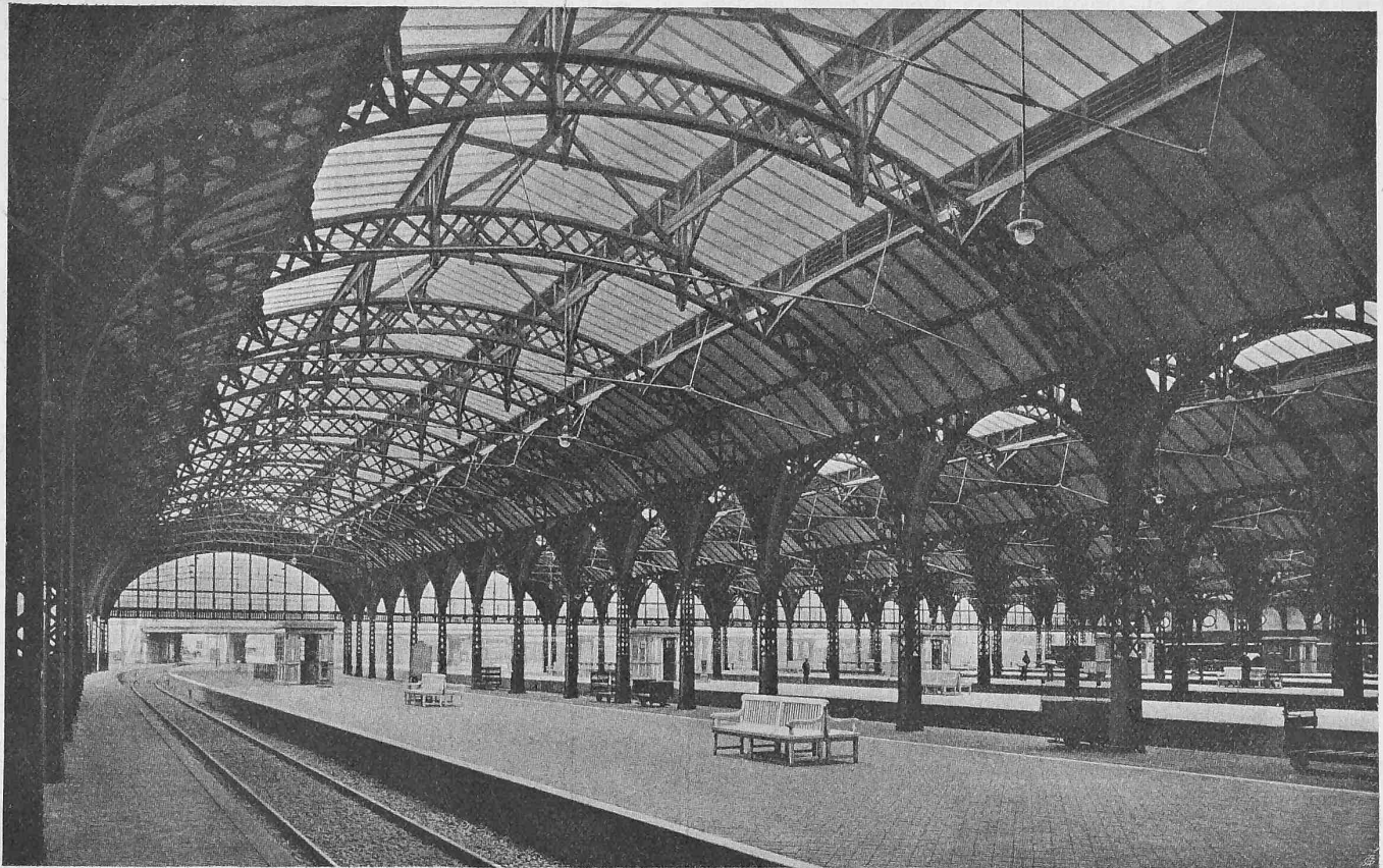
Abb. 17. Bahnsteig-Hallendächer mit hölzernen Fachwerkbindern Bauart Stephan, im neuen Hauptbahnhof in Kopenhagen.
